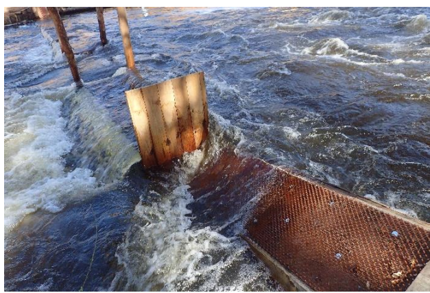
Photo 6.- Détail passe à anguilles
