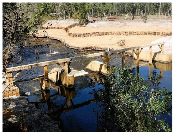
Photo 7.- Face amont du barrage avec portique bois
