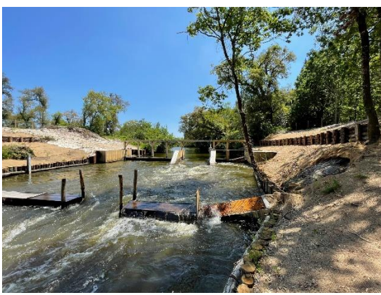
Photo 5.- Echancrure profonde + passe à anguilles
