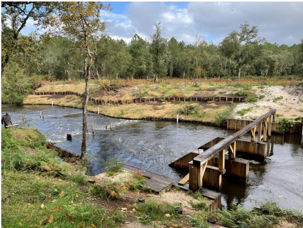
Barrage de la Nasse après travaux de reconstruction – Photo du 05 novembre 2023
