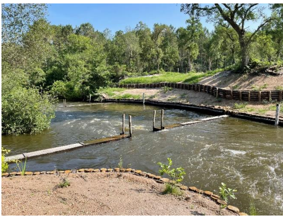
Photo 3.- Exemple de seuil aval (pré-barrage)
