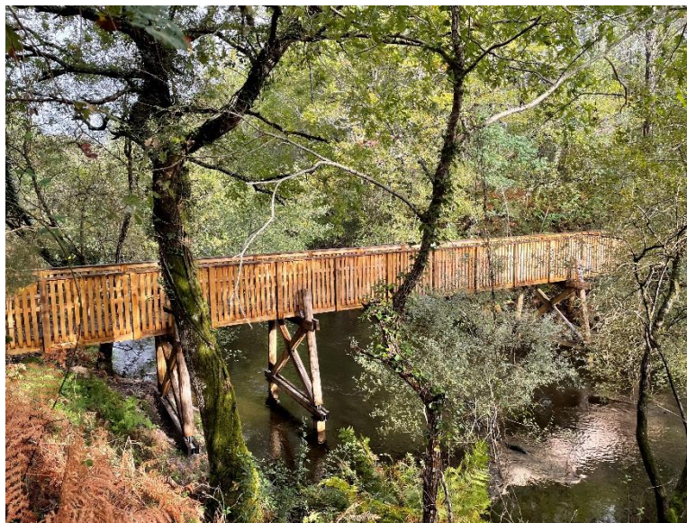
Photo 10.- Passerelle vue amont
