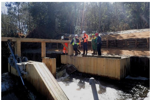
Photo 8.- Détail habillage bois des bajoyers
